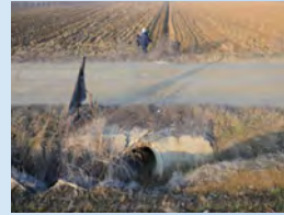
Direkter Gewässeranschluss über Abläufe (Wege/Rohre)
