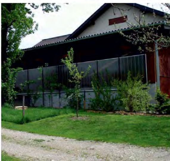
Nordseite, Windschutz zum Fressbereich (LK 00)
