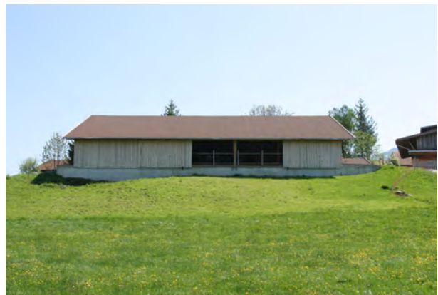
Liegehalle mit geöffneter Außenwand von Süden
