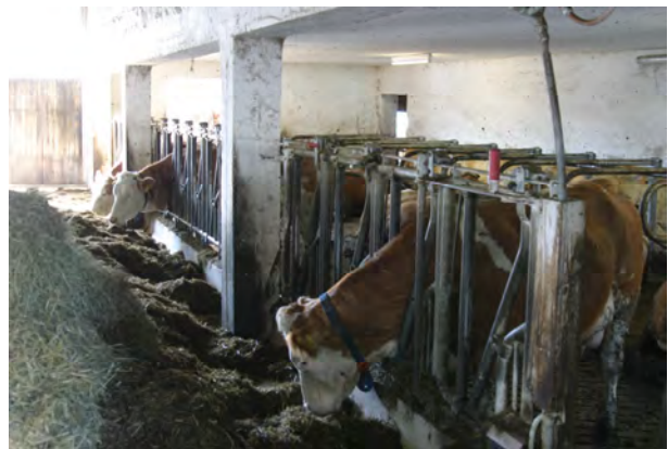
Futterschiff im bestehenden Stallgebäude
