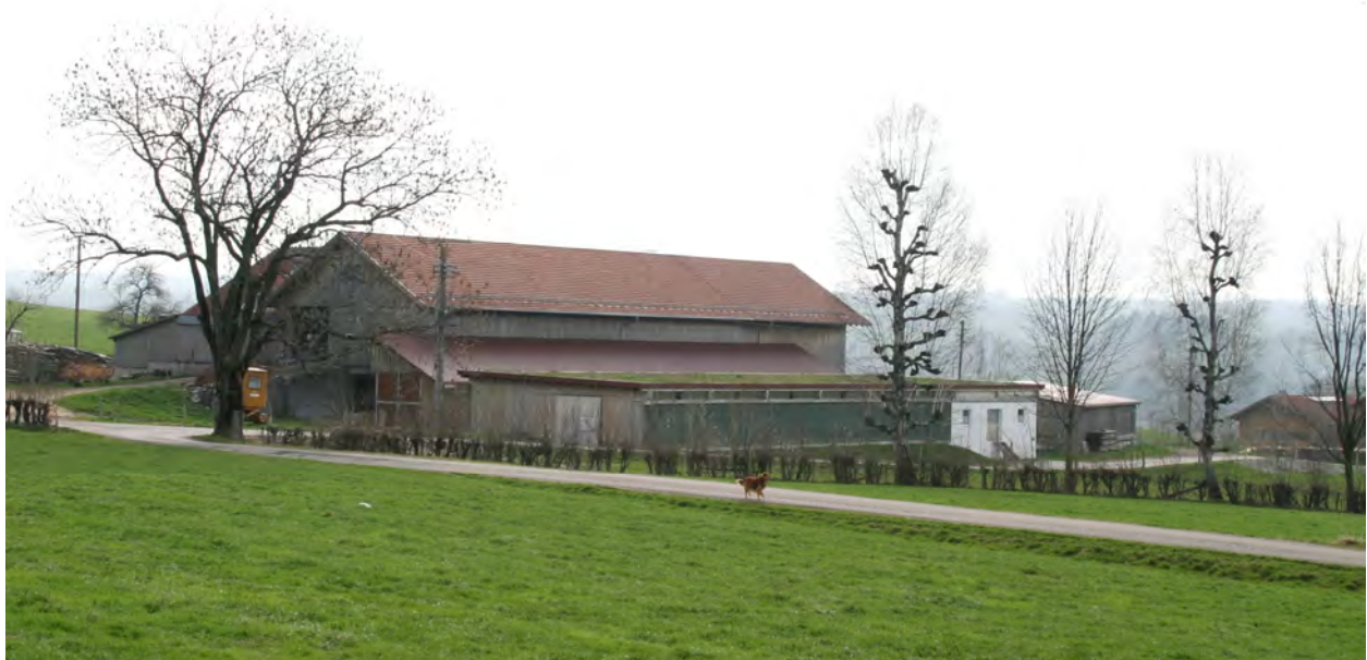
Liegehalle mit Bestandsgebäude von Nord-Westen
