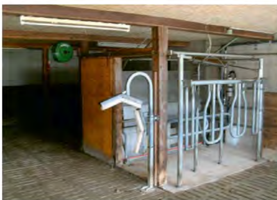
1 x 3 Side-by-Side Melkstand mit Frontabgang zum Futtertisch hin (LK Tirol)
