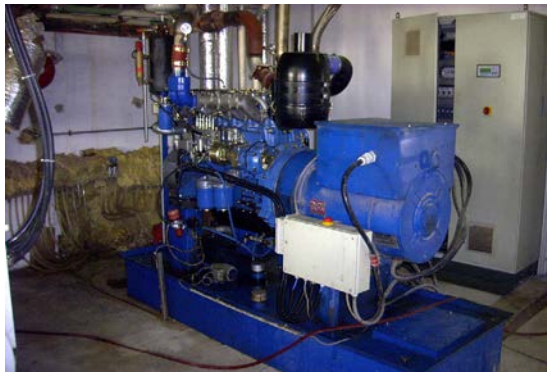
Zündstrahl-BHKW und ermittelte NO x -Werte im Abgas der ersten Messreihe
