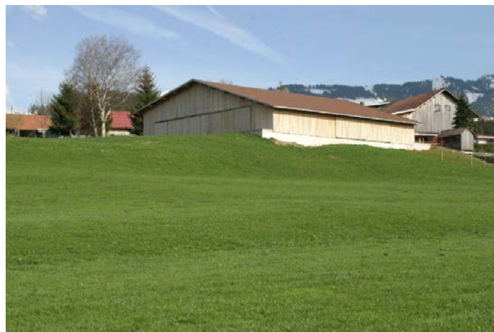
Milchviehstall – Beispiel für die bauliche Gestaltung eines Neubaus am Ortsrand
