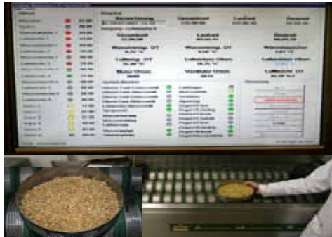
Mälzungsautomat mit Steuerungstechnik
