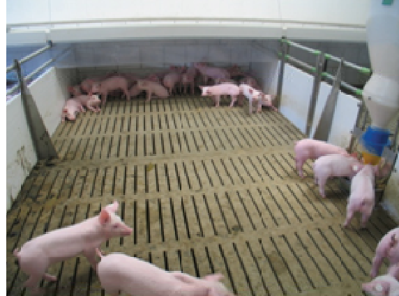
Betonspaltenboden
