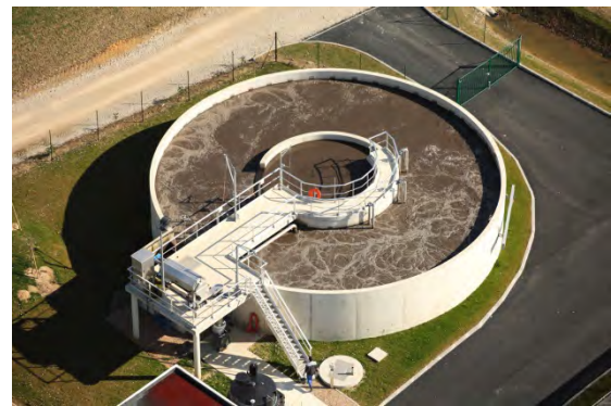
Abb. 14: Belebtschlammbecken einer Kläranlage
